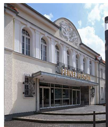
Sehr markantes Bauwerk: Die Peiner Festsäle. Foto: Manfred Zimmermann
